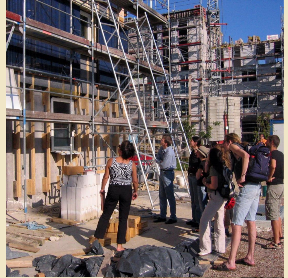
Planungssitzung Baugemeinschaft auf der Baustelle, Foto T. Gauggel
