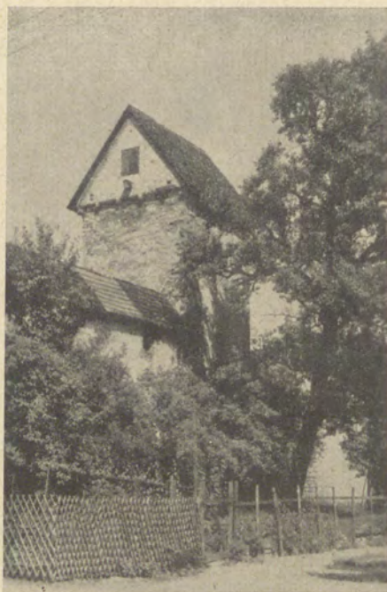
Am Heberlesgraben entlang
