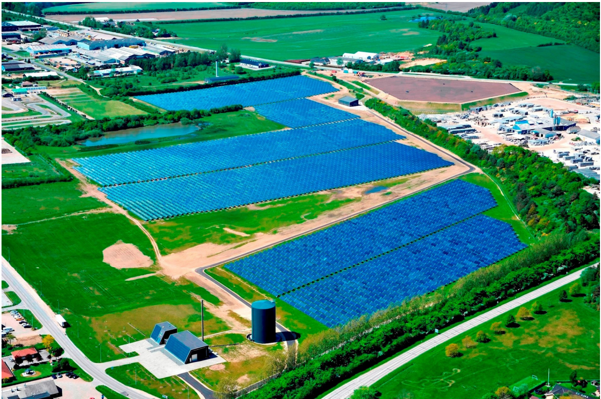
Abb. 30: Solarthermieranlage mit rd. 200.000 m 3 Erdbeckenwärmespeicher (Wärmespeicher oben rechts im Bild. Foto: www.vojensfjernvarme.dk )
