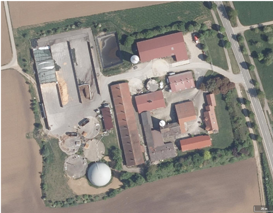
Abb. 35: Luftbild Biogasanlage Ergenzingen
