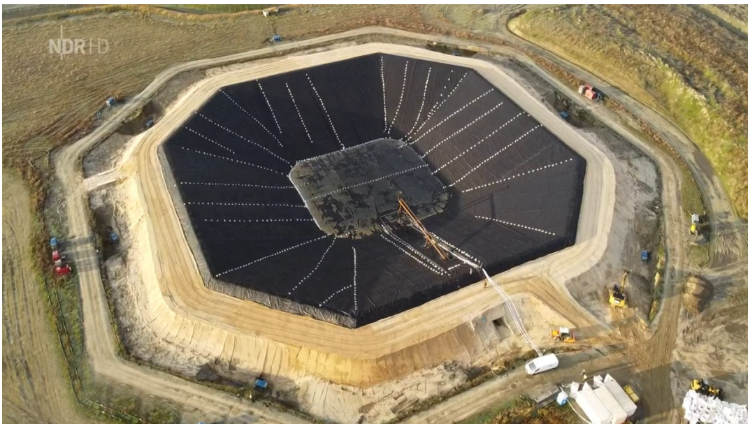
Abb. 31: Bau Erdbeckenwärmespeicher Meldorf mit rd. 43.000 m 3 (Foto: www.ramboll.com )
