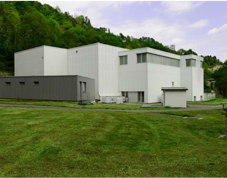
Abb. 15: Bronnach-Wasserwerk Quelle: Stadtwerke Rottenburg
