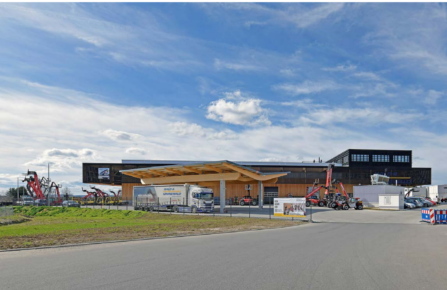
Abb. 23: Gewerbebau mit Holzelementen, Ergenzingen Quelle: Stadtverwaltung Rottenburg
