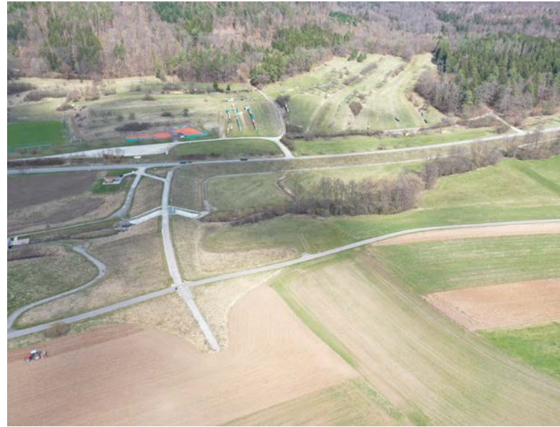
Abb. 13: Hochwasserrückhaltebecken Dettingen Quelle: Stadtverwaltung Rottenburg
