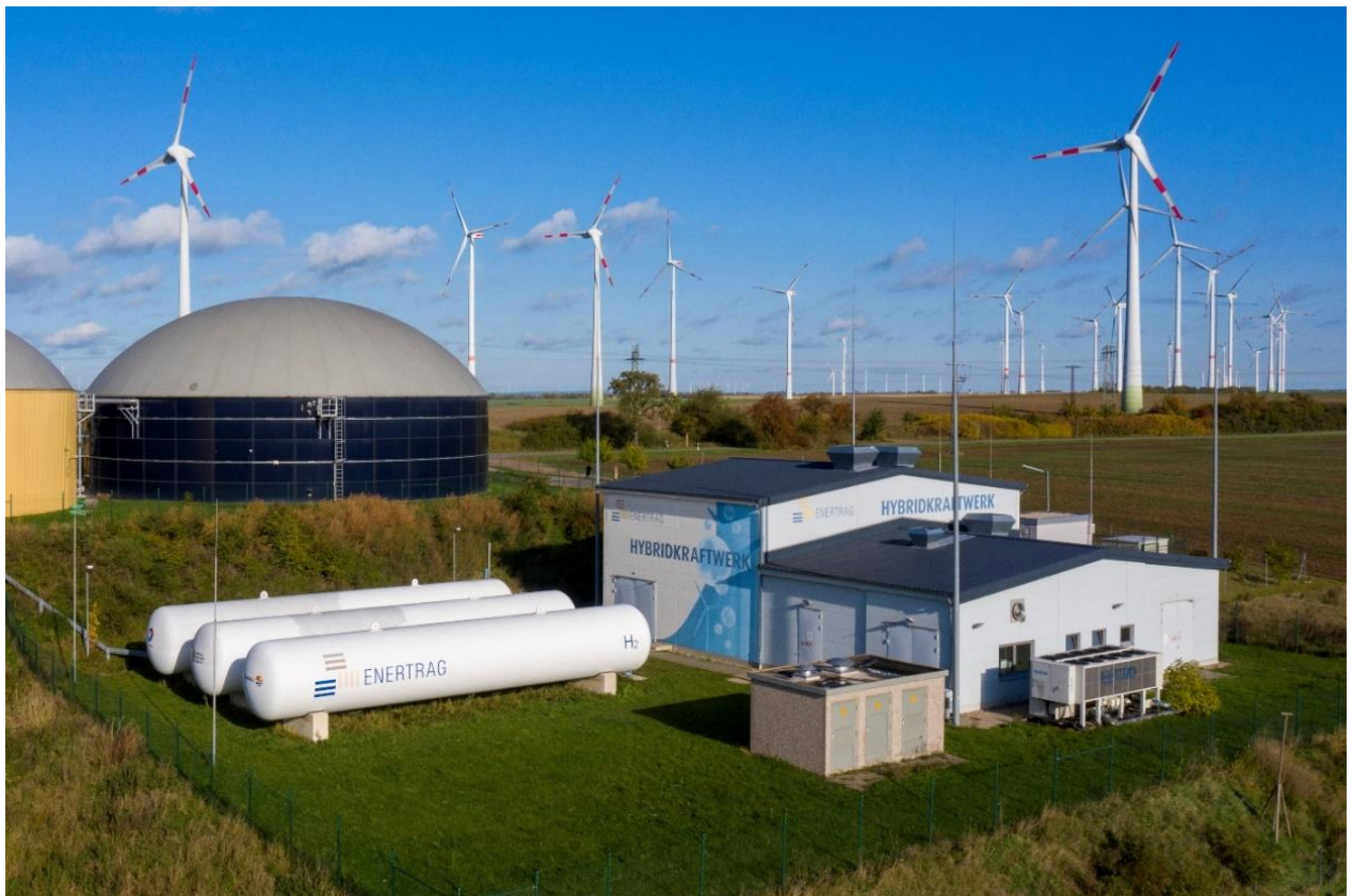
Abb. 55: Beispielanlage Prenzlau, Uckermark (Quelle: ENERTRAG)
