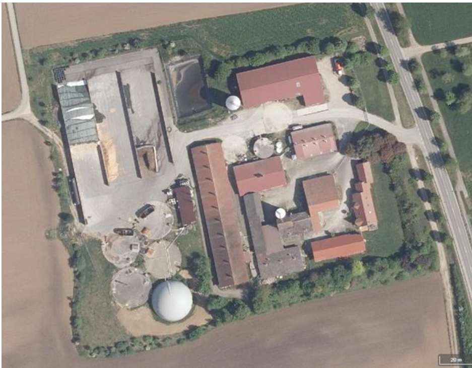
Abb. 41: Luftbild Biogasanlage Ergenzingen
