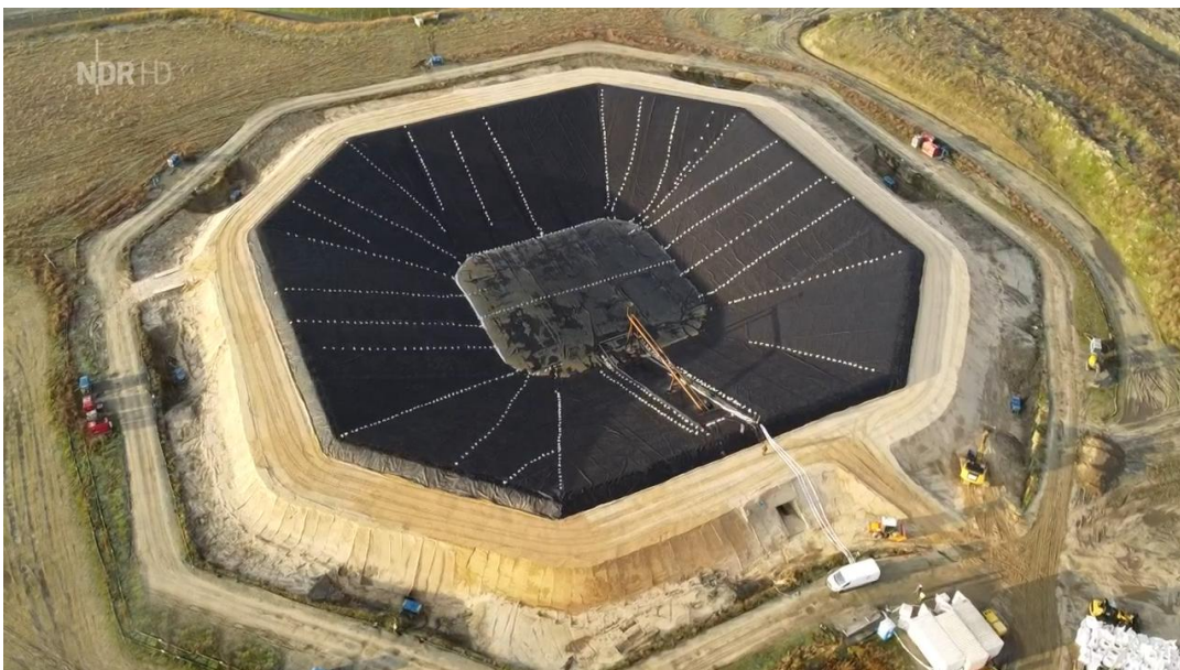
Abb. 37: Bau Erdbeckenwärmespeicher Meldorf mit rd. 43.000 m 3 (Foto: www.ramboll.com )
