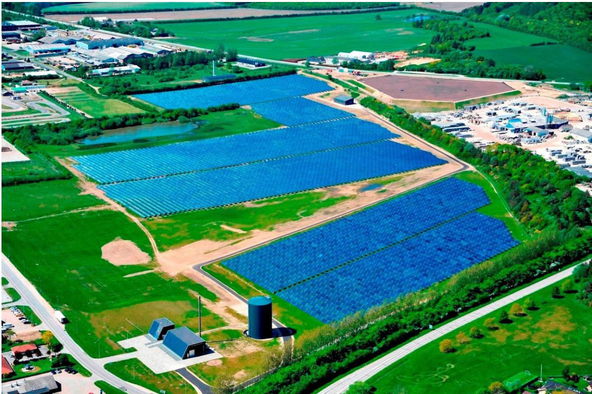
Abb. 36: Solarthermieranlage mit rd. 200.000 m 3 Erdbeckenwärmespeicher (Wärmespeicher oben rechts im Bild. Foto: www.vojensfjernvarme.dk )
