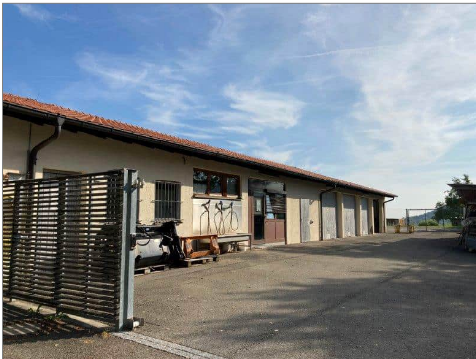
Abb. 8: Gargen-/Werkstattgebäude mit Giebeldach, an der südöstlichen Grenze des Plangebiets (Foto: HPC AG 12.08.2021, Blick nach Nordosten)
