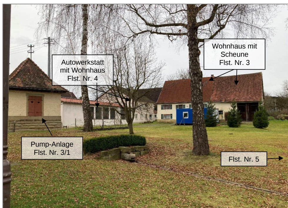
Abb. 7: Plangebiet mit Bestandsgebäuden sowie einzelnen Gehölzen (Foto: HPC AG, 03.01.2022)
