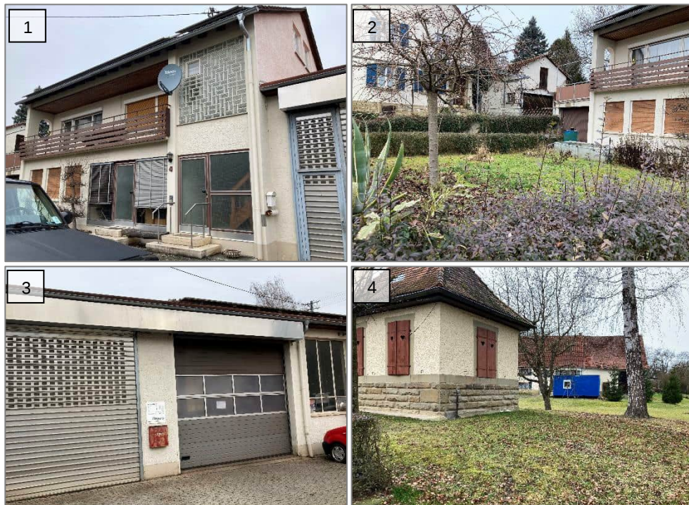
Abb. 10: Bestandsgebäude mit umgebenden Grünflächen auf Flst. Nrn. 4 und 3/1 Foto Nrn. 1 u. 2: Wohnhaus mit Garten auf Flst. Nr. 4 Foto Nr. 3: Autowerkstatt auf Flst. Nr. 4 Foto Nr. 4: Wasserpumpanlage auf Flst. Nr. 3/1 (Fotos: HPC AG, 03.01.2022)
