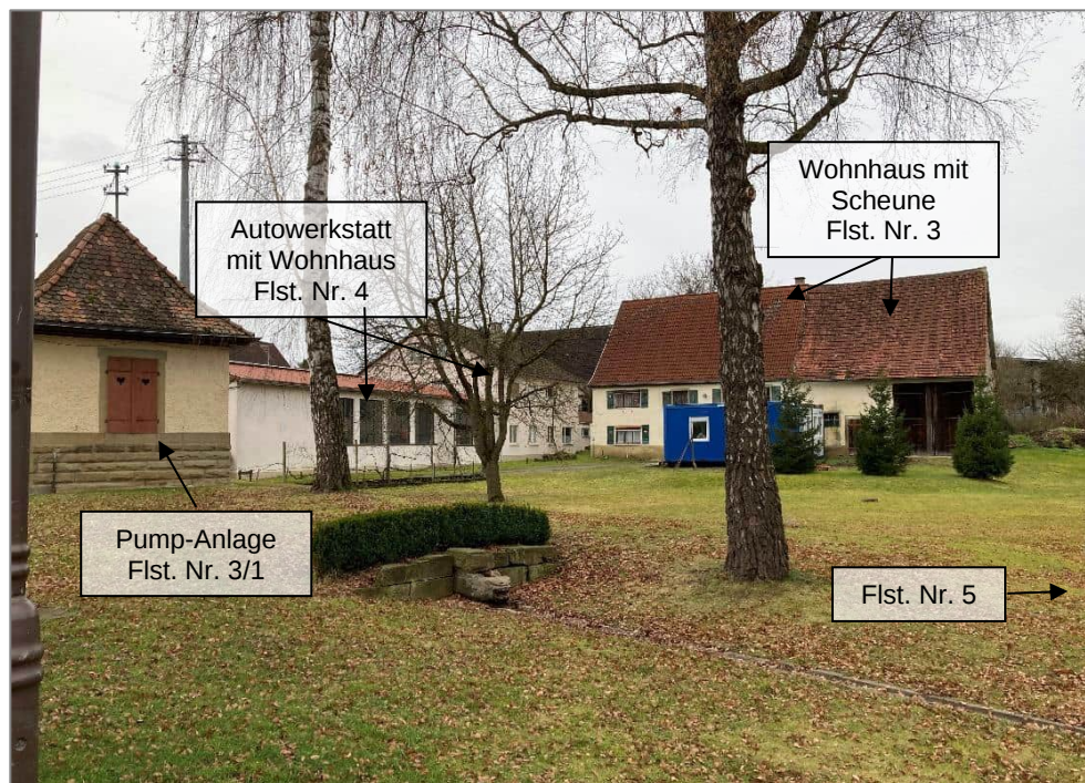
Abb. 2: Plangebiet mit Bestandsgebäuden sowie einzelnen Gehölzen (Foto: HPC AG, 03.01.2022)
