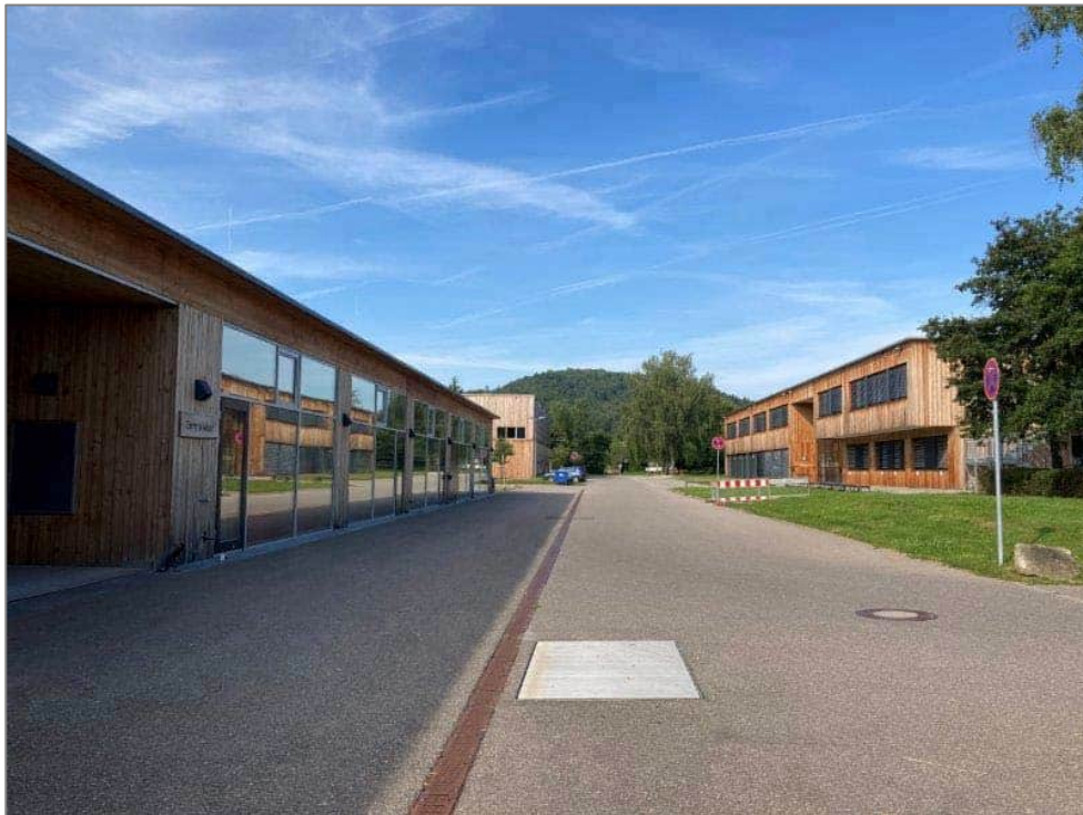
Abb. 9: Flachdachgebäude am südlichen Rand des Campus, entlang der Ausfahrt (Foto: HPC AG 12.08.2021, Blick nach Südwesten)
