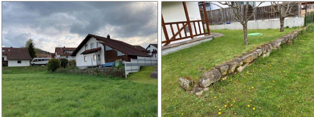
Abb. 10: Ortsrand mit Mauerchen zur Böschungssicherung (Fotos: HPC AG 25.04.2022)
