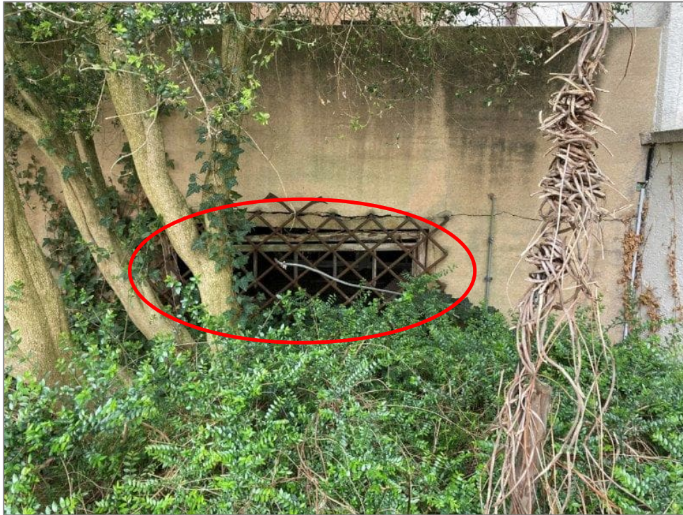
Abb. 9: Kleiner Kellerraum an Westfassade, nahe Eingang (Eberhardstraße 21, Teil FA) (Foto: HPC AG, 04.04.2024)
