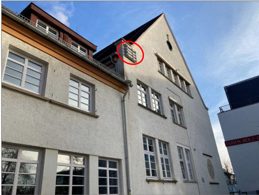
Abb. 17: Mauerseglerkästen (rot umrandet) (Eberhardstraße 21, Teil EBG, Südfassade) (Foto: HPC AG, 04.04.2024)
