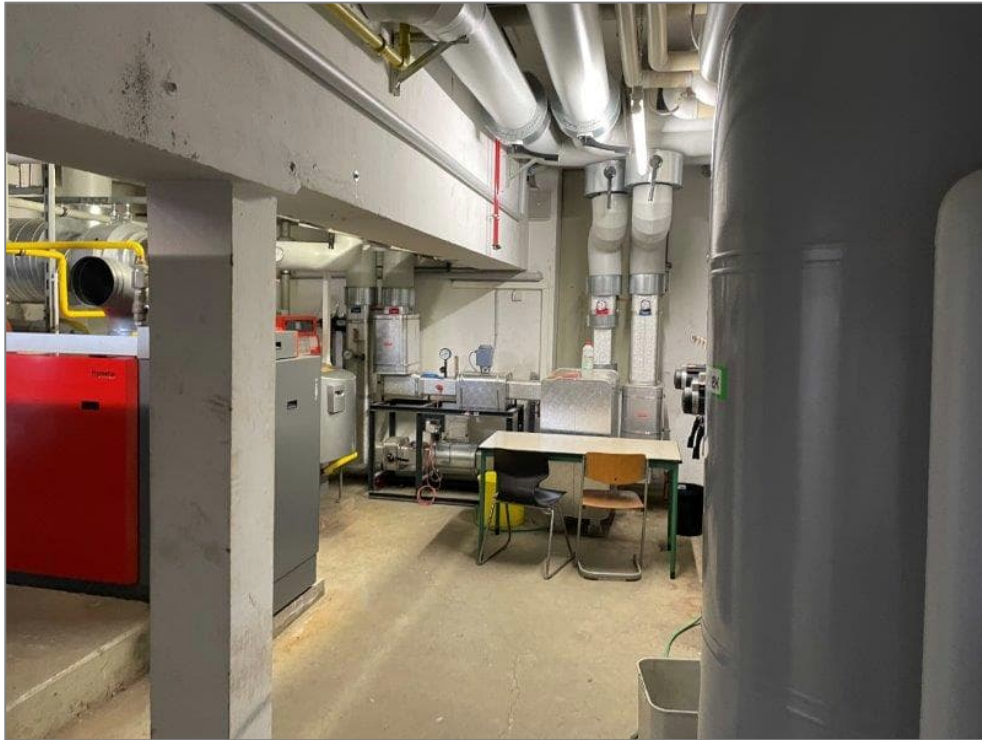
Abb. 13: Kellerraum (Eberhardstraße 21, Teil EBG) (Foto: HPC AG, 04.04.2024)
