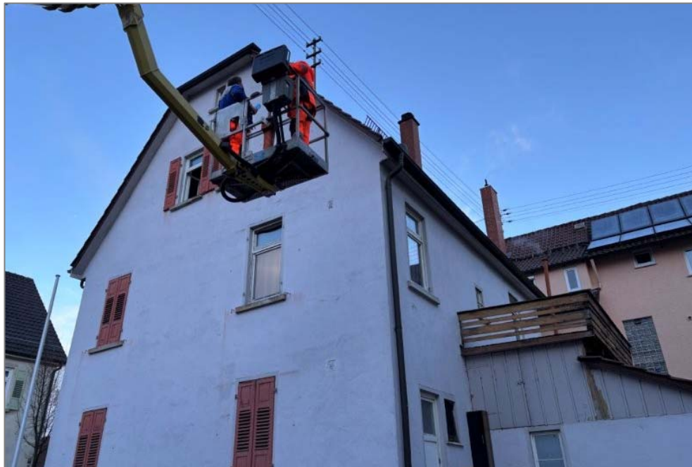
Abb. 1: Mitarbeiter der techn. Betriebe Rottenburg beim Verschließen von Einfluglöchern am Wohnhaus in der Eberhardtstraße 19 (Quelle: HPC AG, 17.02.2026)
