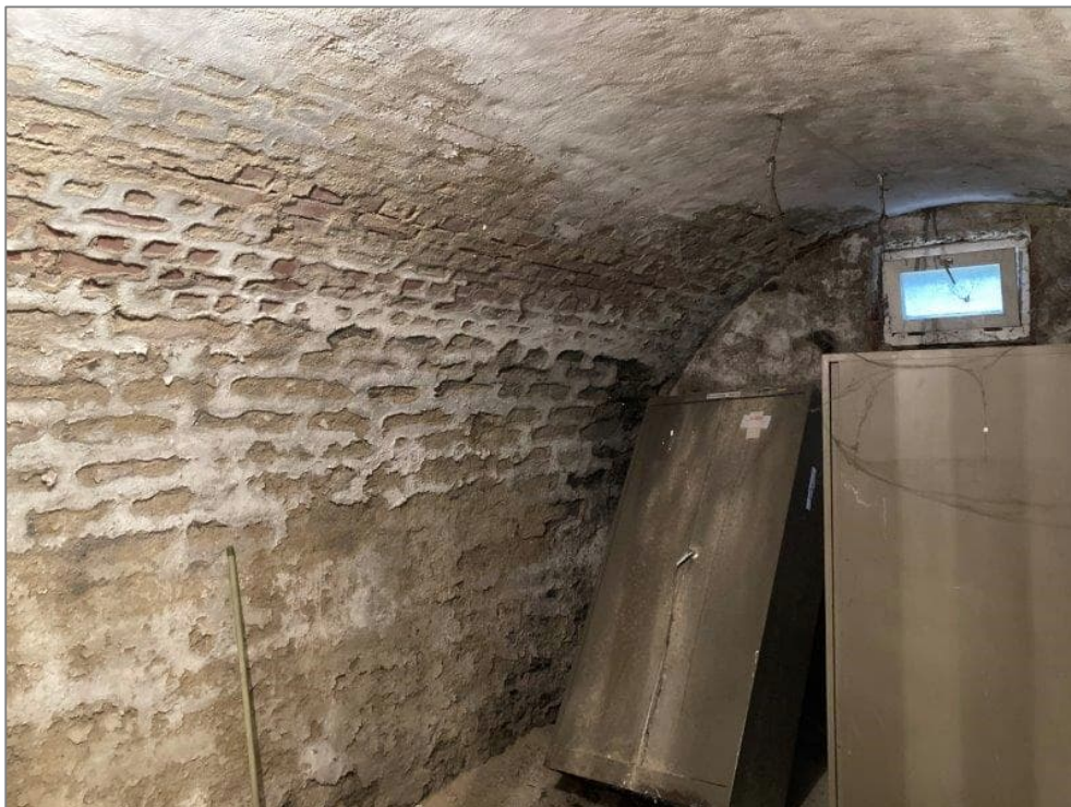
Abb. 10: Gewölbekeller (Eberhardstraße 21, Teil FA) (Foto: HPC AG, 04.04.2024)
