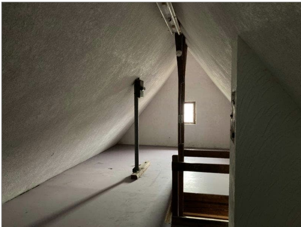
Abb. 6: Dachgeschoss (Eberhardstraße 19) (Foto: HPC AG, 04.04.2024)
