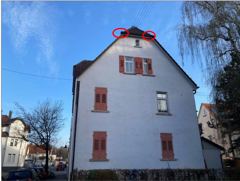
Abb. 7: Südfassade mit Einflugmöglichkeiten (rot) (Eberhardstraße 19) (Foto: HPC AG, 04.04.2024)
