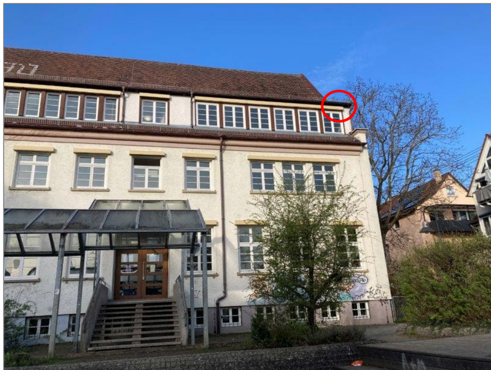
Abb. 16: Nachweis Neststandort (rot umrandet) (Eberhardstraße 21, Teil EBG, Westfassade) (Foto: HPC AG, 04.04.2024)
