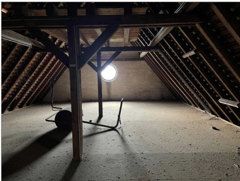
Abb. 14: Dachstuhl (Eberhardstraße 21, Teil EBG) (Foto: HPC AG, 04.04.2024)
