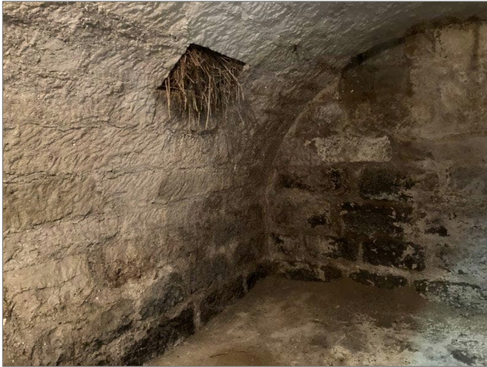
Abb. 5: Gewölbekeller, mit Stroh verschlossene Öffnung (Eberhardstraße 19) (Foto: HPC AG, 04.04.2024)
