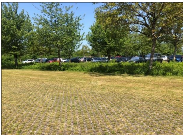
Parkplatz mit wasserdurchlässigem Belag (HHP 2026)
