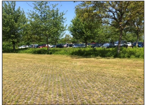
Parkplatz mit wasserdurchlässigem Belag (HHP 2026)
