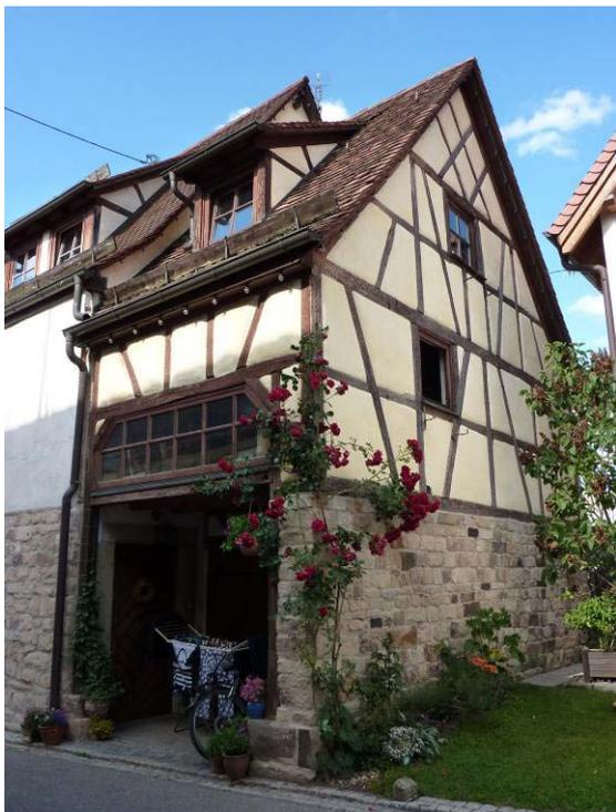
Die Konstruktionsweise ist bei dieser zu Wohnzwecken umgebauten ehemaligen Scheune noch gut zu erkennen. Während der Sockelbereich aus Natursteinmauerwerk besteht, wurde der darauf aufbauende Baukörper aus Fachwerk errichtet. Die ursprüngliche Öffnung des Scheunentores wurde erhalten.
