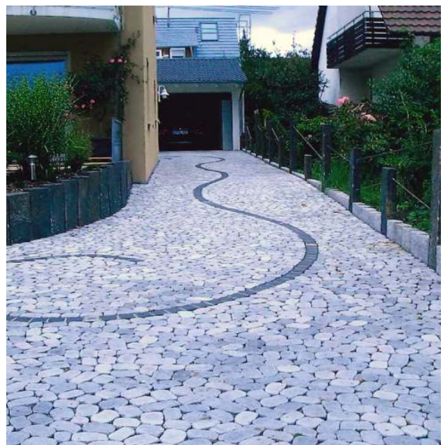
Abb. 34 Hof nach der Umgestaltung mit versickerungsfähigem Fugenstein
