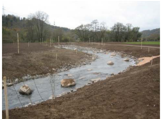
Abb. 1: Umgehungsgerinne nach Abschluss der Bauarbeiten 2006
