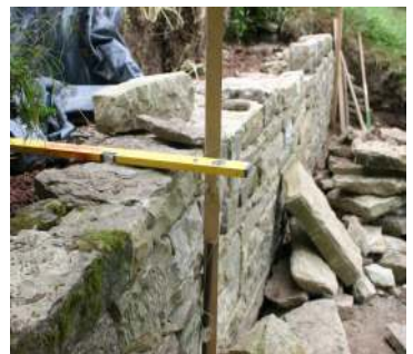
Abb. 35/36: Der Bau bzw. Wiederaufbau einer Trockenmauer erfordert Fachkompetenz bei der Wahl von Binder- und Decksteinen, dem Schotterbett zur Drainage, der Verarbeitung der Steine und nicht zuletzt dem "Anlauf", d. h. einer leichten Schräglage gegen den Hang, welche der Hangbelastung entgegenwirkt.
