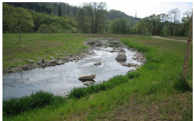
Abb. 2: Umgehungsgerinne ein Jahr nach der Fertigstellung
