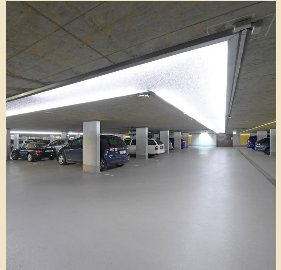
gemeinschaftliche Tiefgarage Hof 1 Alte Weberei Tübingen, Architektur Baisch + Fritz Tübingen, Foto G. De Maddalena
